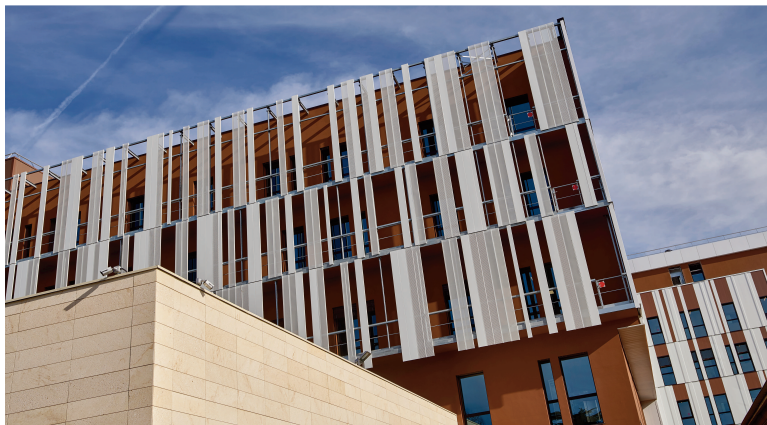
Façade sud-ouest du nouvel hôpital Robert BOULIN
