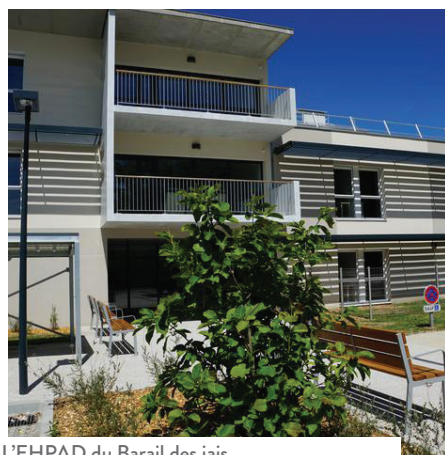
L'EHPAD du Barail des jais
