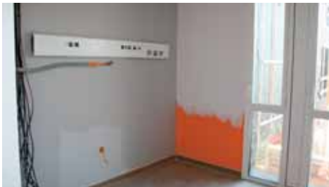
La pose des bandeaux-tête de lit
