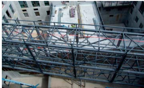
La galerie reliant le NHL au monobloc est en cours d'installation
