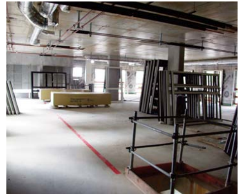
La pose des cloisons a débuté sur plusieurs niveaux et progresse bien. Les grands espaces de béton disparaissent petit à petit pour laisser place aux futures salles de l'Hôpital de jour.
