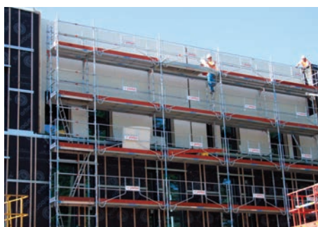
La pose des façades a débuté
