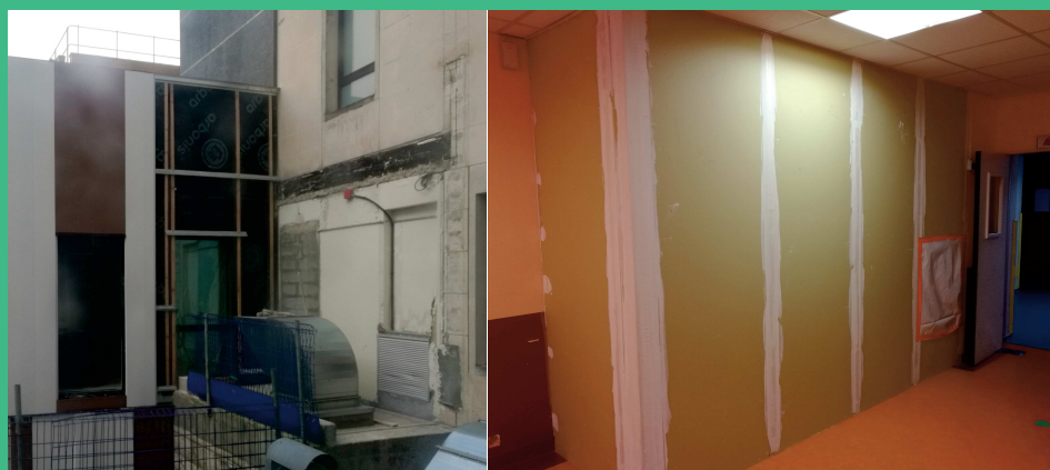
La jonction nouveau/ancien presque achevée à hauteur des salles de naissances
