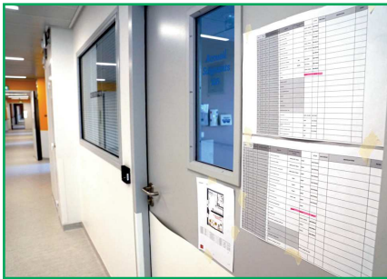
Afin de préparer les livraisons, chaque pièce est identifiée avec une fiche espace, décrivant quels équipements doivent y être installés.
