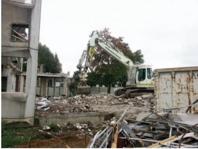
Démolition et préparation du terrain
