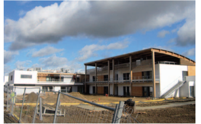
Le chantier en cours
