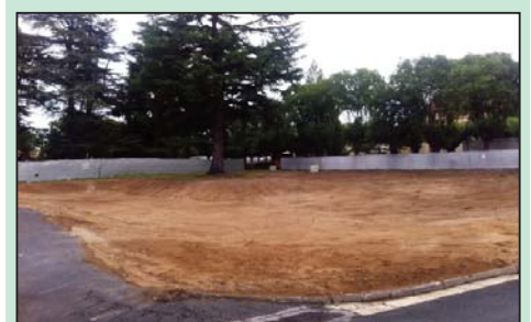
Une fois le terrassement et le déblaiement achevés...
