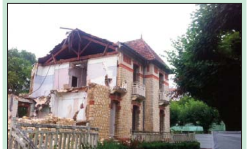
La démolition des anciens pavillons débute
