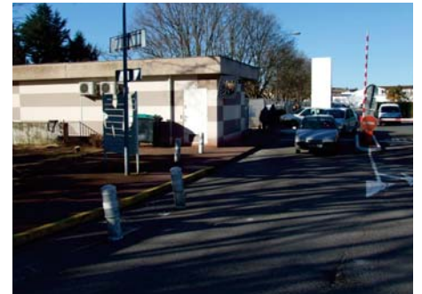
L'autocommutateur, dernière démolition symbolique!
