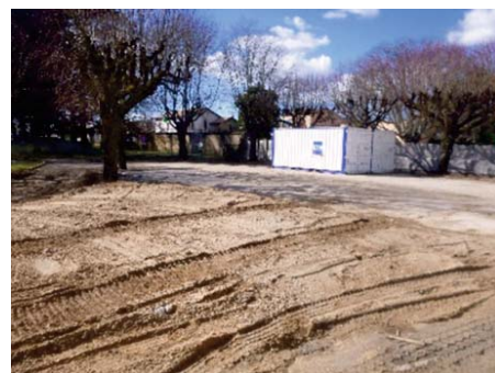
Préparation de l'emplacement des bureaux
