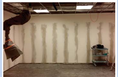
La salle a été entièrement adaptée aux nouvelles normes
