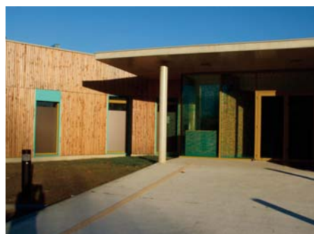
L'entrée principale du nouveau pavillon baptisé ULISS
