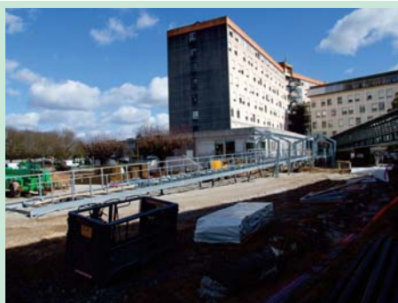
La passerelle identifiera clairement l'entrée provisoire de Boulin
