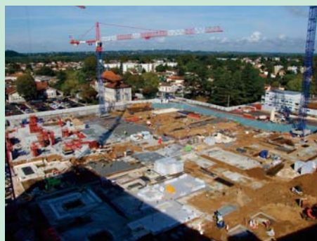
Le chantier prêt pour la 1ère pierre
