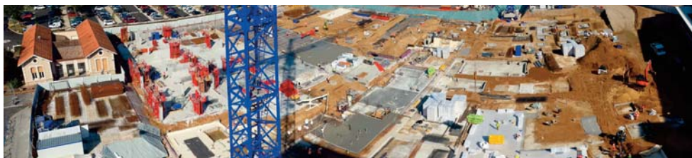
Le chantier en configuration « gros oeuvre »
