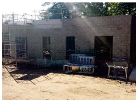
Le bâtiment témoin en construction
