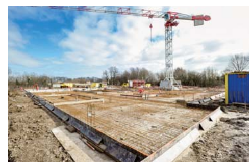
Au moment de la cérémonie, les fondations étaient en cours...
