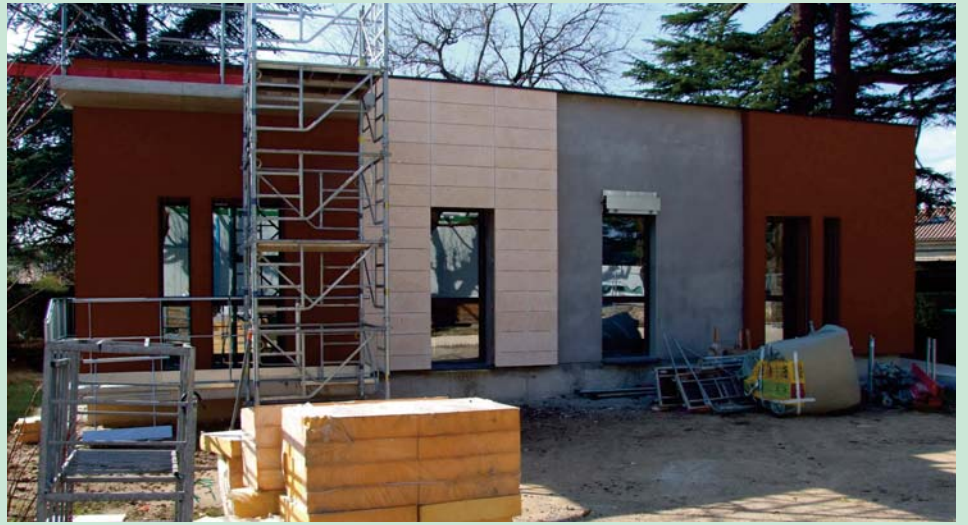
Le pavillon témoin a également permis aux équipes de GTM de s'essayer par exemple à la pose des façades avant l'exécution réelle
