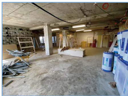
Le Noyau central du 2 e étage qui accueillait autrefois les salles d'attente
