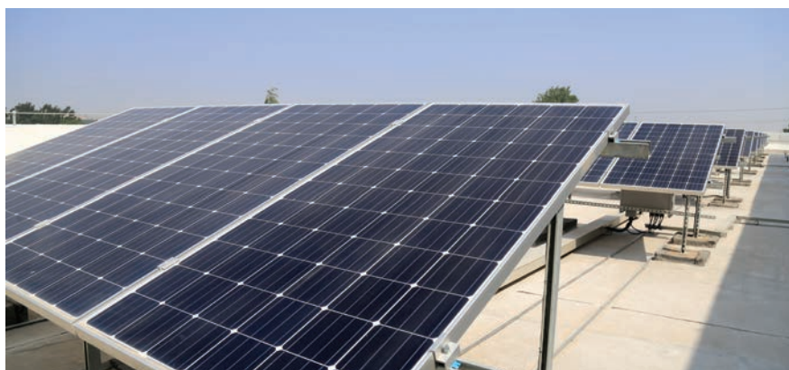
L'installation des 180 m 2 de panneaux photovoltaïques se fera sur les toitures de l'EHPAD
