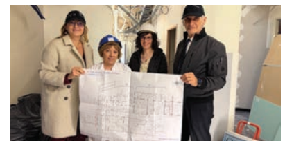
Présentation sur le chantier par M. Laffargue Directeur délégué du CH de Sainte Foy, et son équipe
